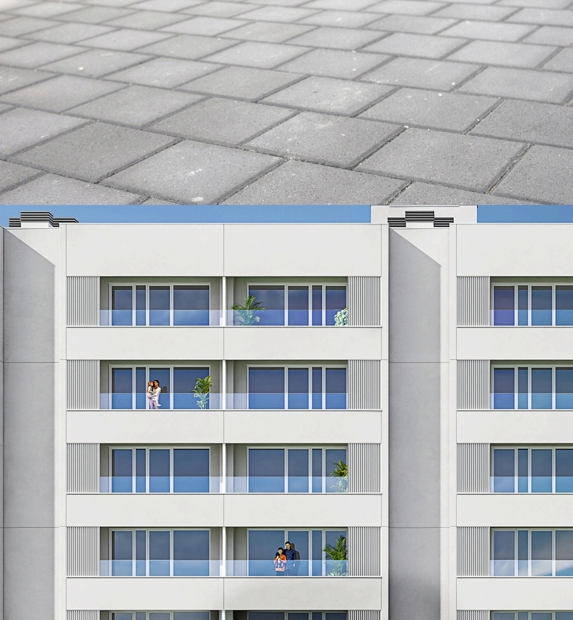
La carpintería exterior es de PVC en color blanco con rotura de puente térmico, colocada sobre premarcos tipo "monoblock". Las persianas de lamas de aluminio con aislamiento de poliuretano en su interior.
